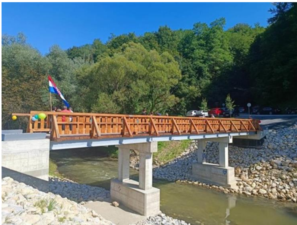
Slika 1. Most na rijeci Bednji u Lovrentovcu [2]
