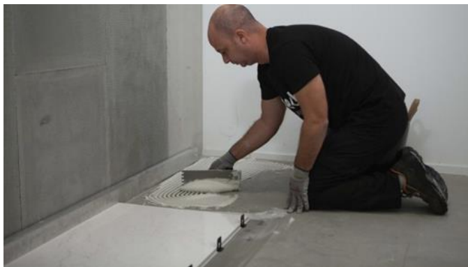
Slika 12. Proces instalacije pločica
