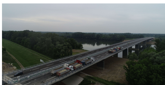
Slika 13. - Postavljanje opterećenja u položaj za statičko ispitivanje
