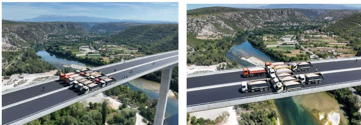
Slika 12. - Postavljanje opterećenja u položaj za statičko ispitivanje
