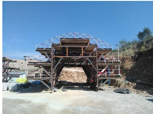
Slika 5. Prikaz čelične tunelske skele, tunel Vjeternik, Crna Gora [2]
