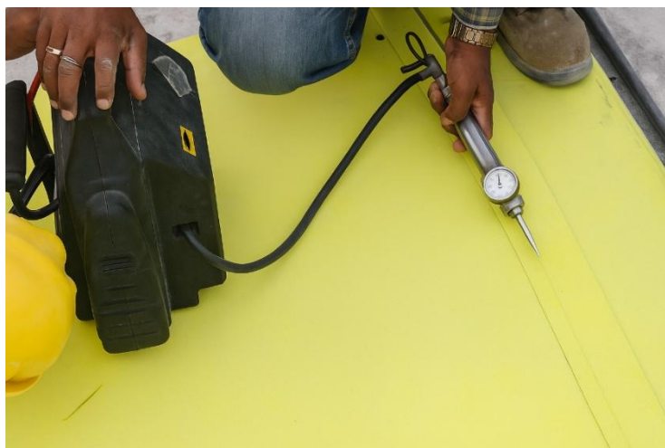
Slika 8. Prikaz ispitivanja spojeva komprimiranim vazduhom [8]
