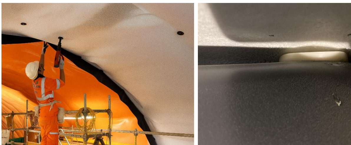
Slika 2. Prikaz pričvršćivanja zaštitnog filca i hidroizolacijske membrane [3]
