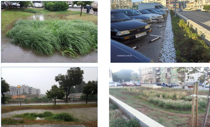
Slika 5. Izgrađeni NbS sustavi Nazorove ulice (Starum) [6]
