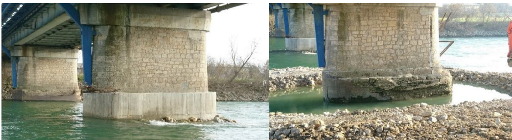
Slika 8. Pogled s desne obale na stupove mosta Podsused: a) prethodno sanirani srednji stup (lijevo); b) desni stup tijekom sanacije (desno)
