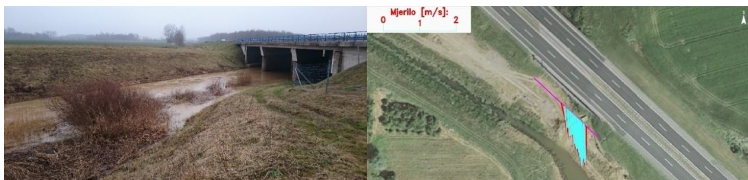
Slika 4. Lateralni kanal: a) suženje protočnog profila uzvodno od mosta, pogled s desne obale (lijevo); b) prevaljeni profil brzine toka na ortofoto podlozi (desno)
