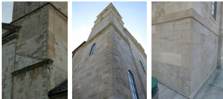
Slike 19.-21. Primjer izgradnje zidnih plaštava južnog zvonika Crkve Sv. Petra i Pavla na Gorici u Livnu, različitim vrstama klesanaca s obzirom na njihovu boju, veličinu i površinsku obradu (lijevo), [29]; Kamen muljika, koji daje posebnu monumentalnost glavnom pročelju H, obnovljen je na pročelju i zvonnicima, (sredina i desno; foto: K. Šaravanja), [6]
