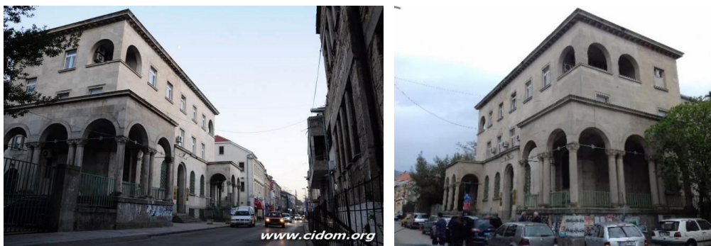
Slike 11.-12. Donji dio kamenog sjeverozapadnog pročelja zgrade bivše SDK u Mostaru (lijevo, www.cidom.org ) je izraženije prekriven površinskim naslagama nečistoće od jugozapadnog dijela pročelja (desno); Postanak ovih naslaga je prouzročen kombinacijom faktora vezanih uz onečišćenje zraka (od prometa, grijanja kućanstava i industrije) i djelovanje vlage na kamen, (foto: K. Šaravanja), [6]
