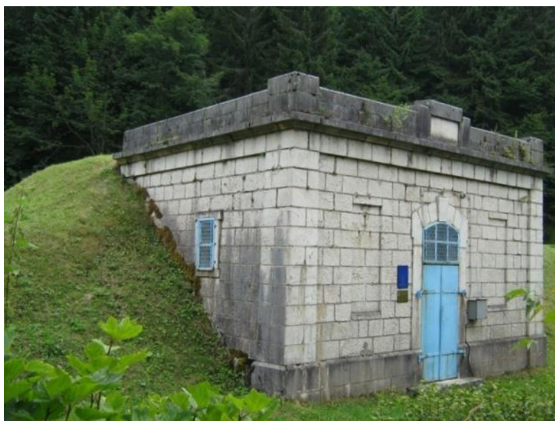
Slika 6. Kaptažna građevina na vrelu Bistrica
