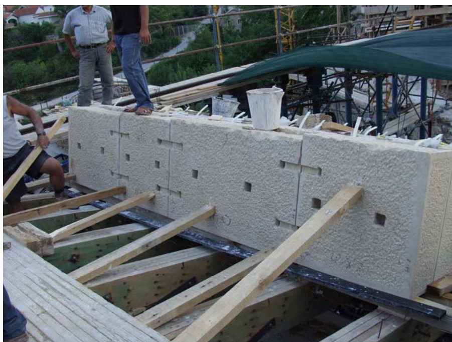
Slika 5. Zidanje luka (Foto: Omega engineering)
