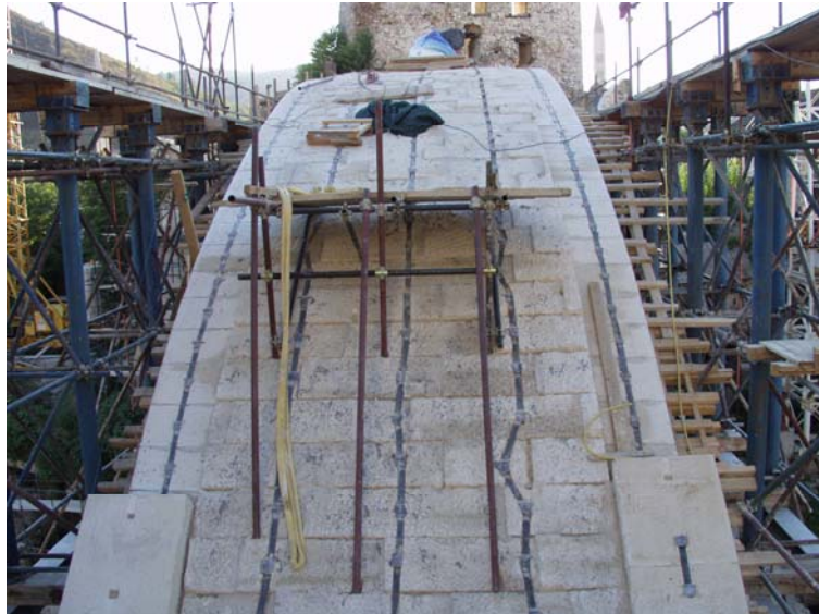
Slika 6. Pregled završenog luka s istočne strane (Foto: Omega engineering)
