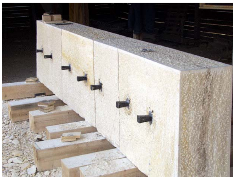
Slika 4. Pripremljen jedan red luka (Foto: Omega engineering)
