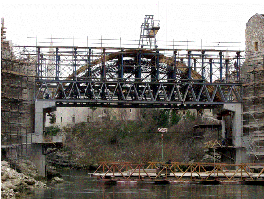
Slika 3. Čelična skela luka Starog mosta (Foto: Omega engineering)
