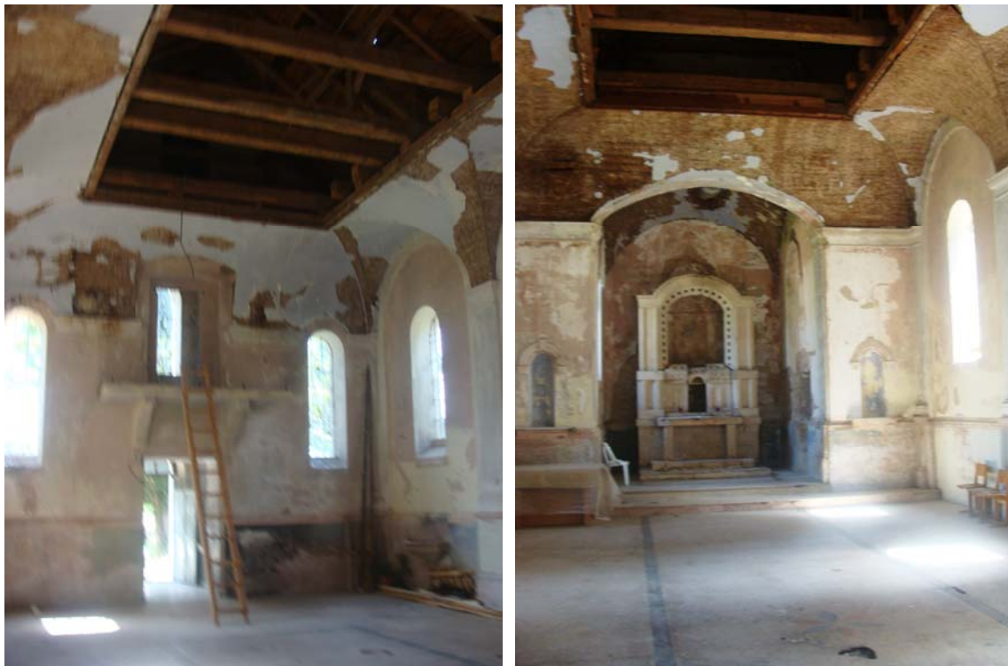
Slika 17. Unutrašnjost crkve tijekom obnove
