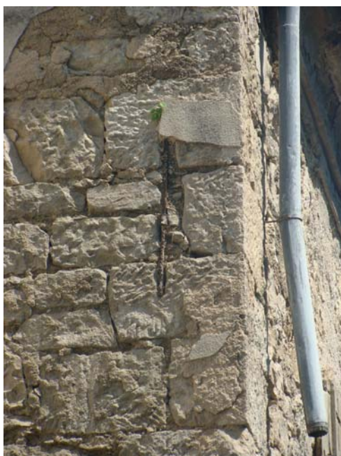
Slika 16. Kameni zidovi sa potresnom zategom
